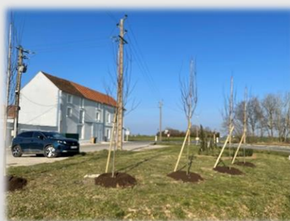
3 mars : les végétaux sont mis en place
