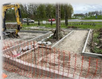
11 avril : les bordures sont mises en place.
