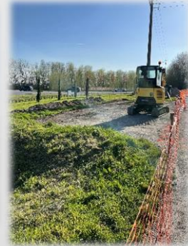
5 avril : travaux de terrassement
