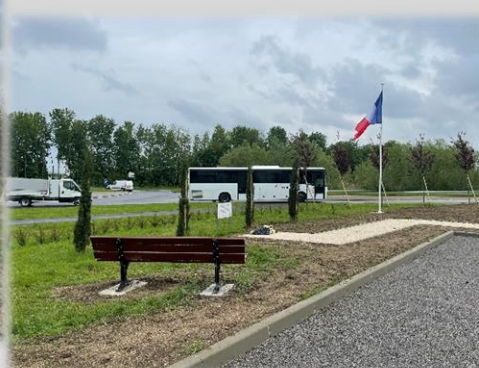
11 mai : installation du mat porteur du drapeau et du banc.
