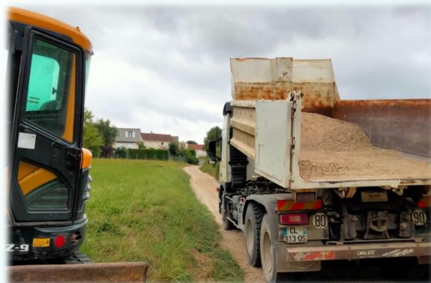
Terrassement du chemin des Margotins
